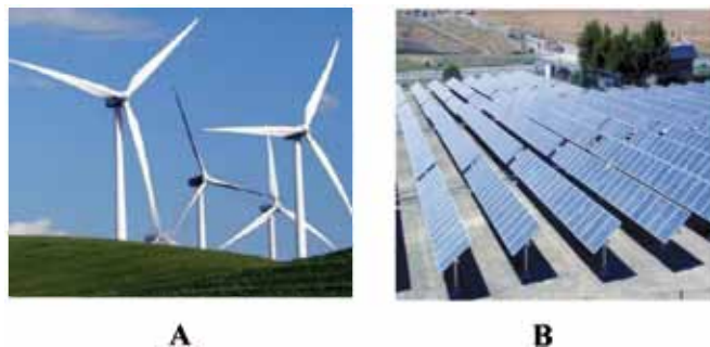
Fig. 14. – A) un campo di torri eoliche; B) un campo di pannelli fotovoltaici.
